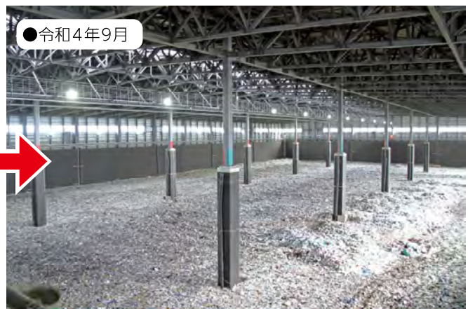
▲現在は、高さ約2.5m程度まで堆積。当初予定計画の埋め立て量から大幅に削減できています。
