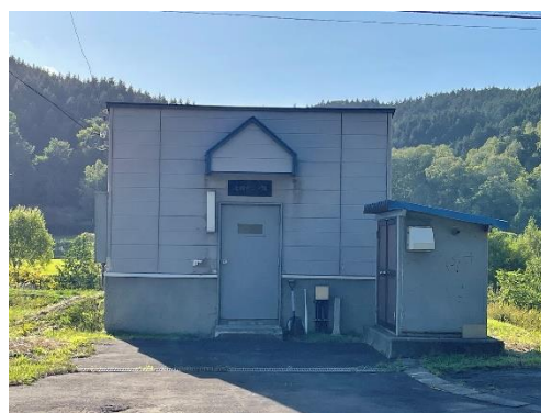
◇ 北線ポンプ場
