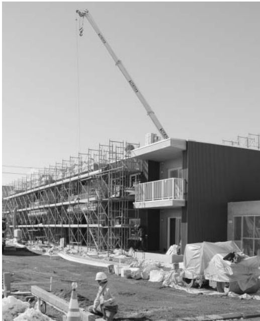
建設がすすむ西団地C棟(3月上旬撮影)
