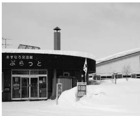
(仮称)高齢者福祉センターは、「ぶらっと」に隣接して建設する予定
