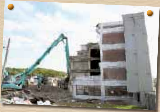
▲旧庁舎の解体工事が進んでいます
