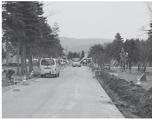
工事が進む水郷公園
