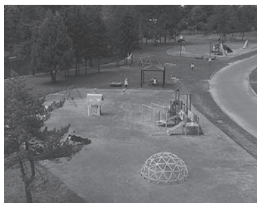
たくましいまち 【つくも水郷公園再整備】
