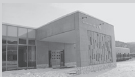
朝日地域交流施設「和が舎」
