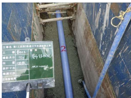
〈汚水管布設状況〉
