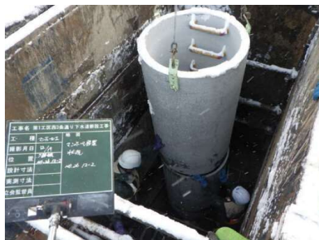
〈マンホール設置状況〉
