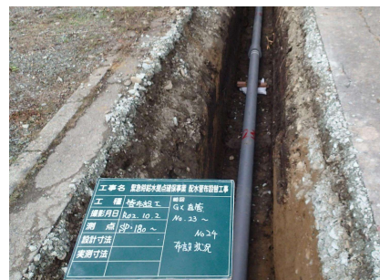
〈配水管布設状況〉
