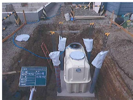
〈浄化槽設置状況〉
