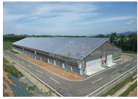
低炭素社会に向けたバイオマス資源堆肥化施設
