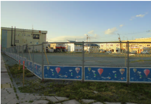
工事が始まった (仮称)まちなか交流プラザ
