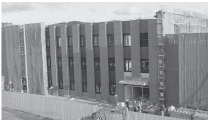
建設中の市役所新庁舎（R1.9.25撮影）
