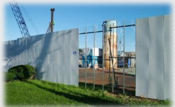
▲来庁者駐車場付近の「のぞき窓」
