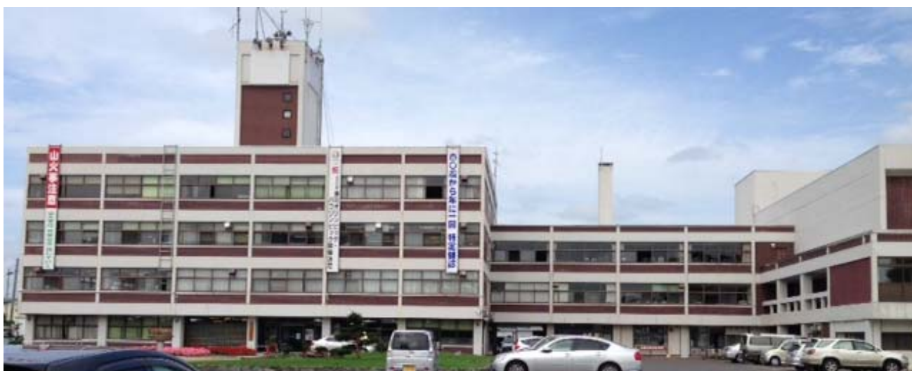
築50年以上が経過した本庁舎
