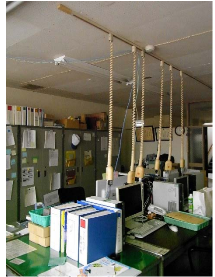
視線を遮る天井からの配線
