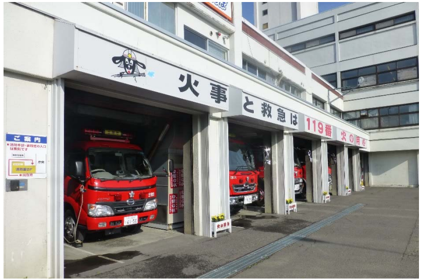
耐震性能が低く狭い消防車庫
