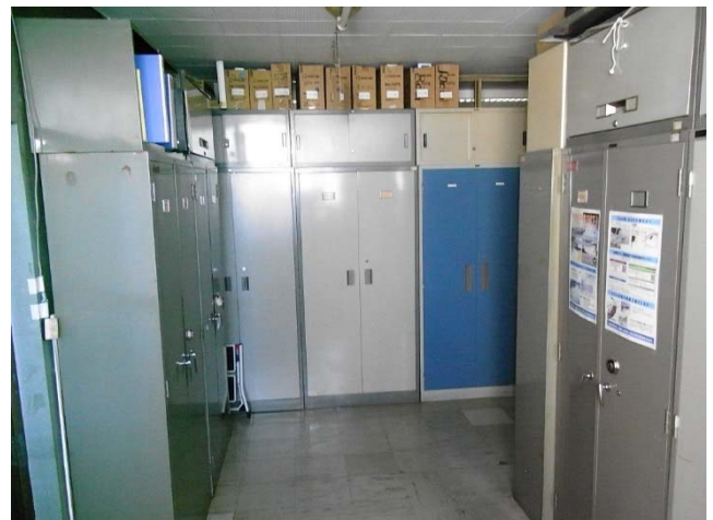
廊下に配置したロッカー
