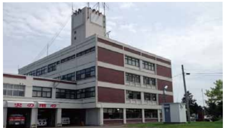
築50年を超え老朽化が著しい本庁舎
