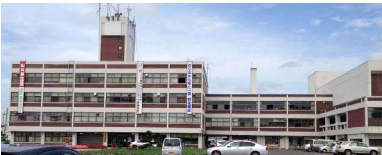
築50年以上が経過した本庁舎
