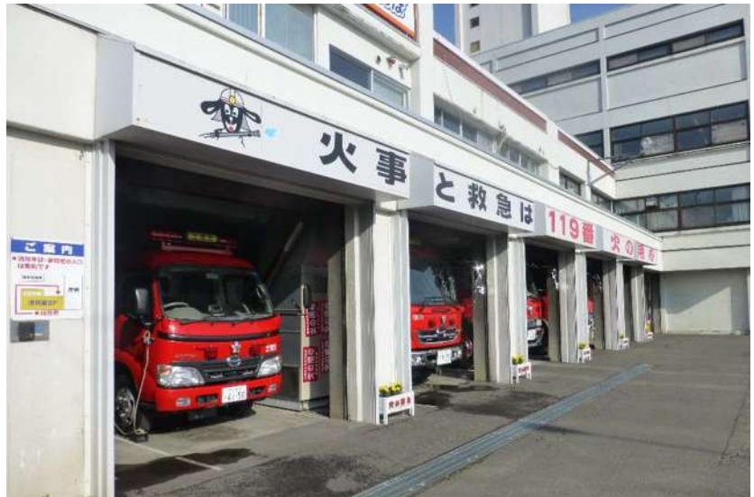
耐震性能が低く狭い消防車庫
