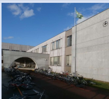
外壁(正面玄関周辺)
