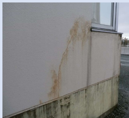
外壁(サッシ周辺)
