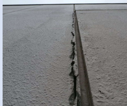
外壁(目地周辺)
