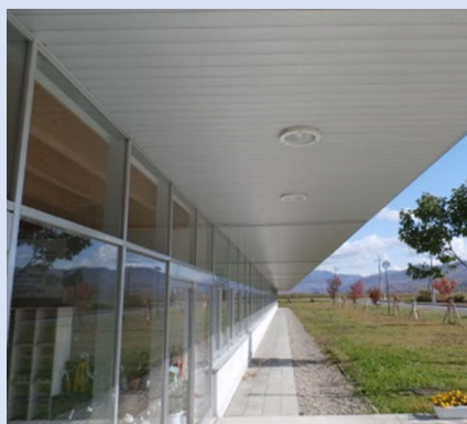
外壁(校舎南面)
