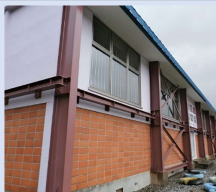
体育館(壁面耐震補強)
