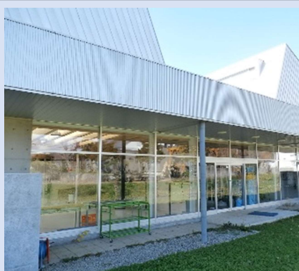
外壁・庇(菜園出入口)
