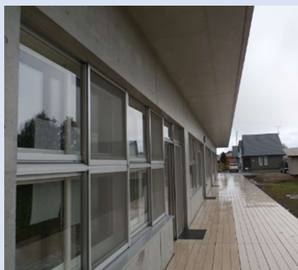
外壁(校舎南面)
