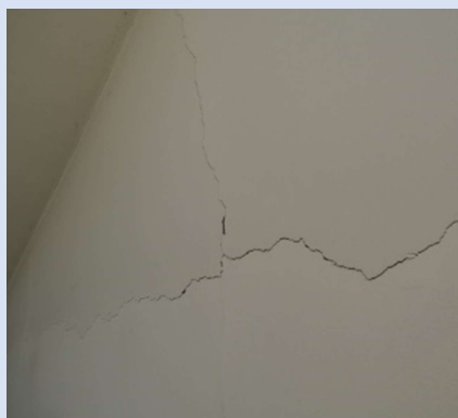
階段壁面(校舎1)
