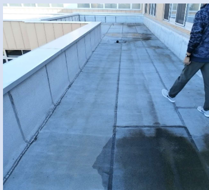
屋上(アスファルト防水)
