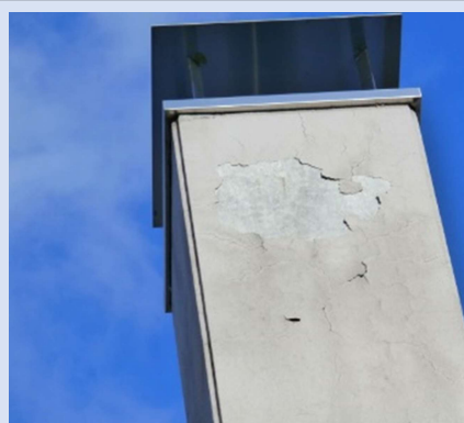
ボイラー煙突
