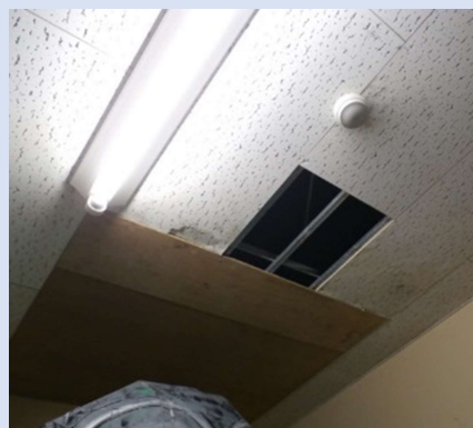
西器具庫天井
