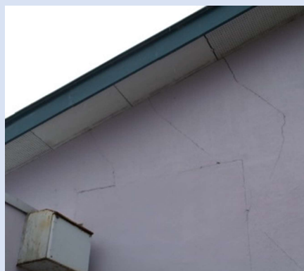
体育館トイレ外壁(体育館付属部)
