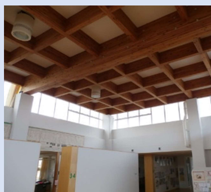
天井(多目的スペース)
