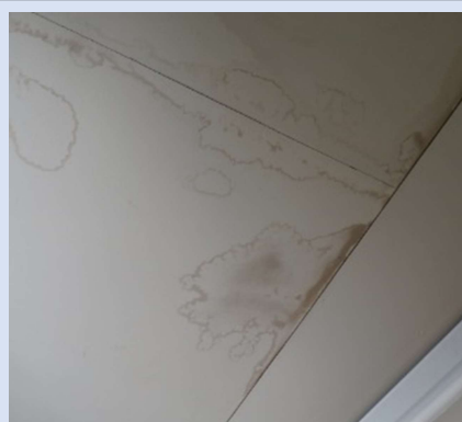
天井(渡り廊下)
