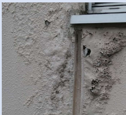
外壁(サッシ周辺)
