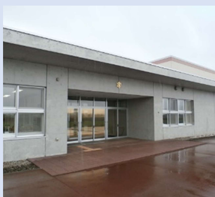
外壁(玄関周辺)
