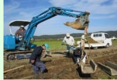
コンクリート水路の更新
