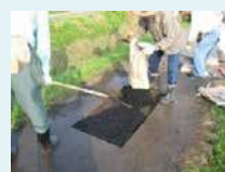
農道の部分補修
