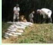
漏水箇所の補修
