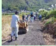
未舗装農道の舗装
