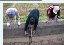
施設の機能診断
