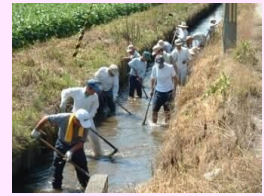
水路の泥上げ
