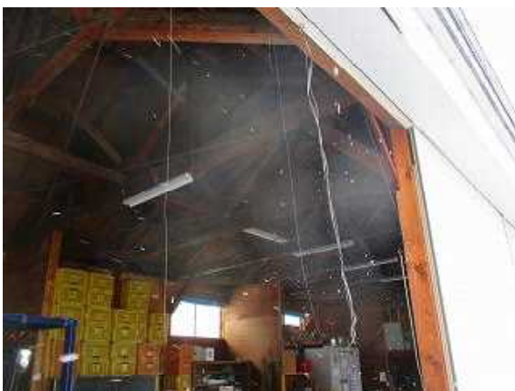
写真3 施設出入り口にひもを設置
