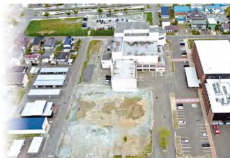
▲市役所本庁舎の外構工事
